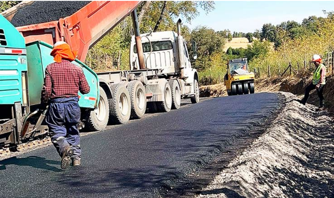
$17.000 millones se destinarían a intervenir 42,13 kilómetros de caminos rurales.
