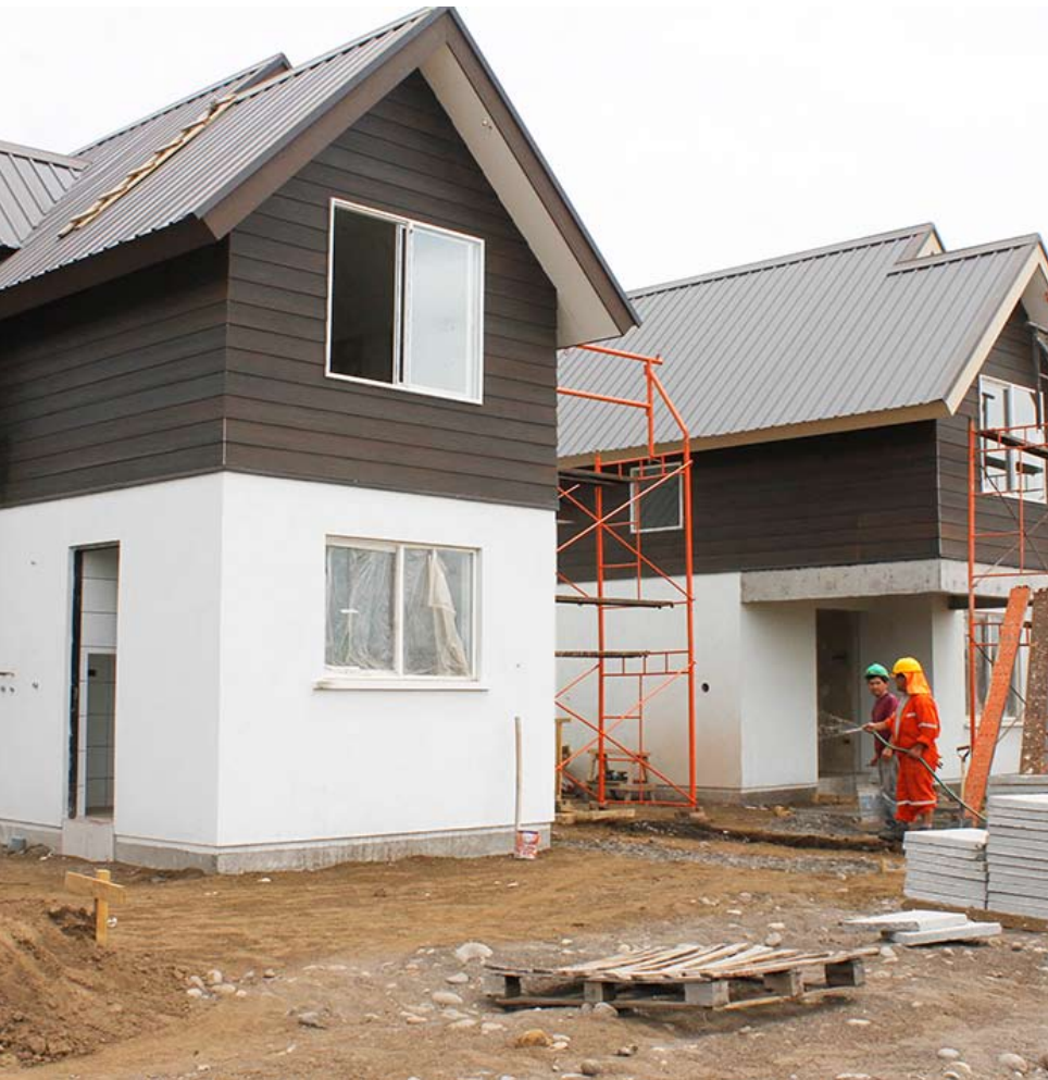
Durante su construcción demandará una mano de obra promedio de 90 trabajadores.
