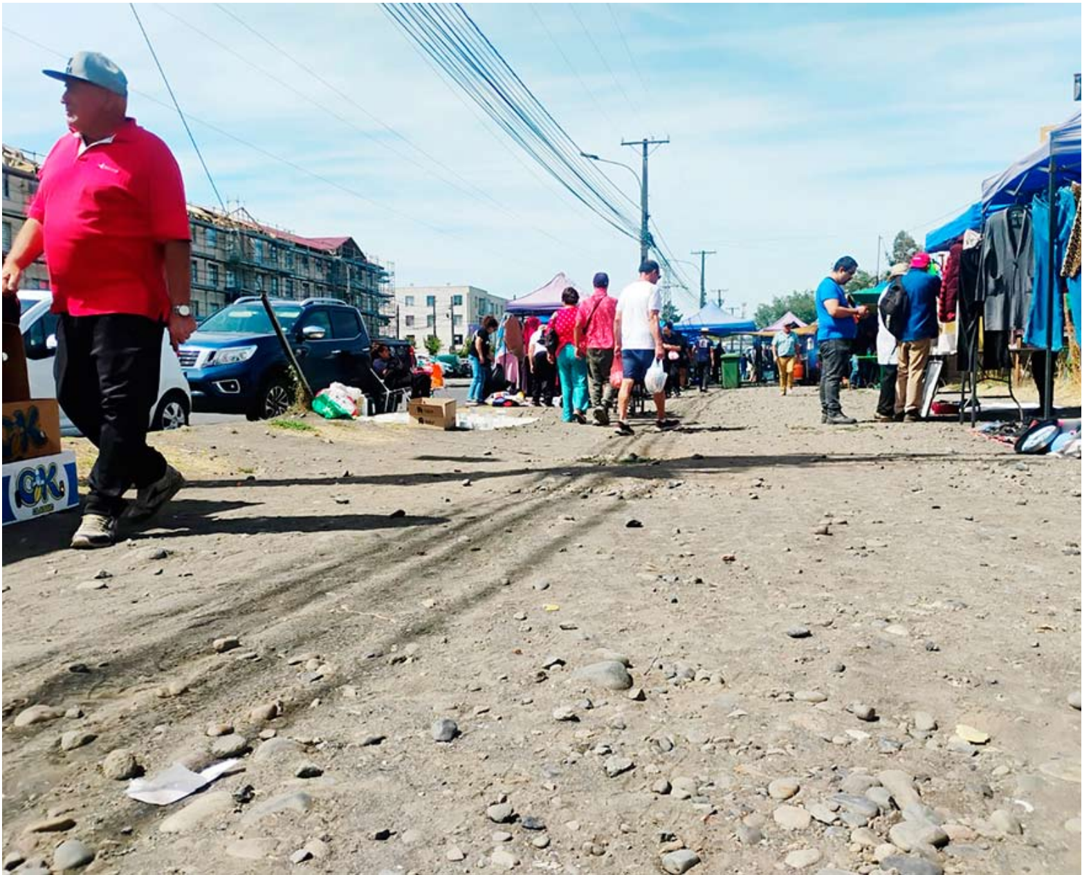
Con la lluvia la tierra se convierte en barro. Esperan que ese tramo se pueda pavimentar.
