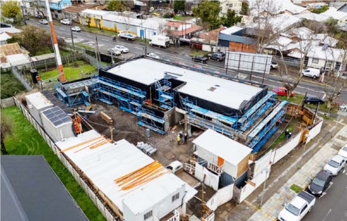
Cuadrillas en terreno avanzan en la instalación de revestimientos interiores y exteriores.
